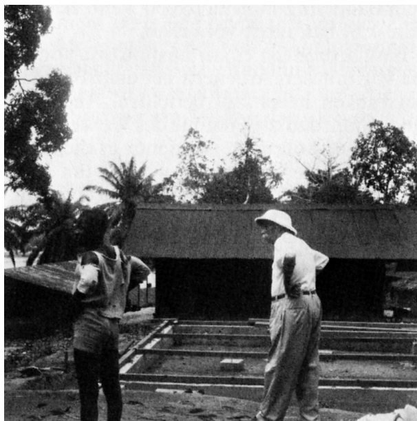
À Lambaréné, sur un chantier de l'hôpital (dans les années 60).
